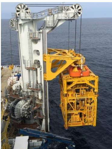
Die Installation des Åsgard-Subsea-Moduls - © Statoil
