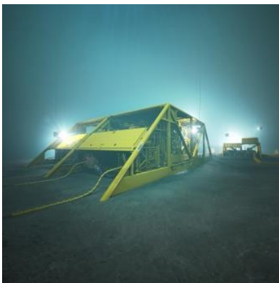
Åsgard's Unterwasser-Kompressorstation am Meeresboden installiert – © Aker Solutions
